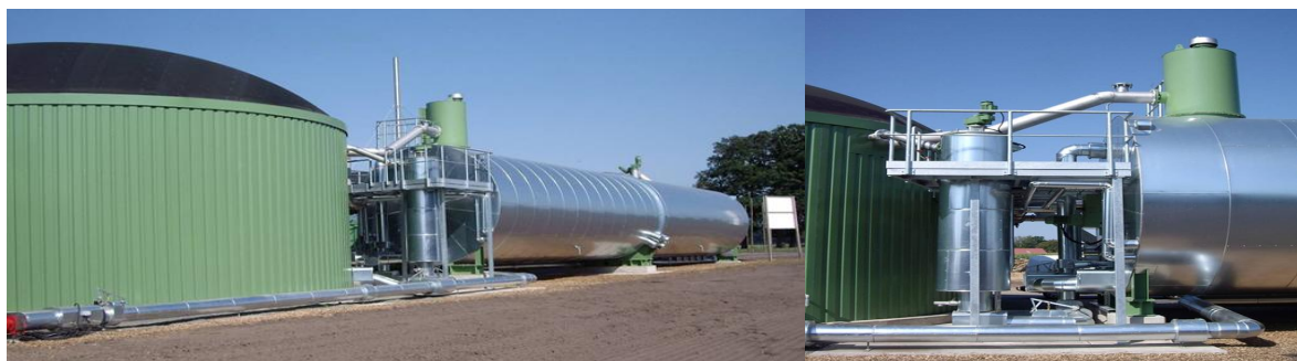
Фигура 5. Инсталация за биогаз с непрекъснат процес
